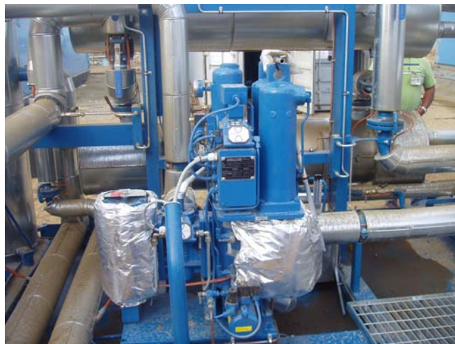
Afbeelding 6. Automatisch brandstoffilter Boll en Kirch. Bron WEB Aruba.
